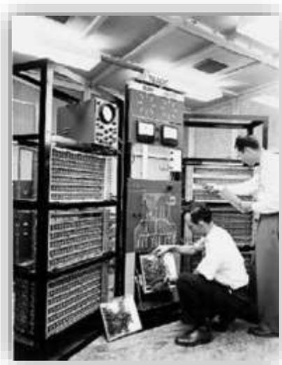
La **segunda generación** se inicia cuando aparecen las primeras computadoras a partir de transistores, sustituyendo a las que funcionaban con bulbos. Los laboratorios Bell construyeron, en 1954, la primera computadora transistorizada, la TRADIC (*transistorized airborne digital computer*), cuya estructura interna incluía 800 transistores.
